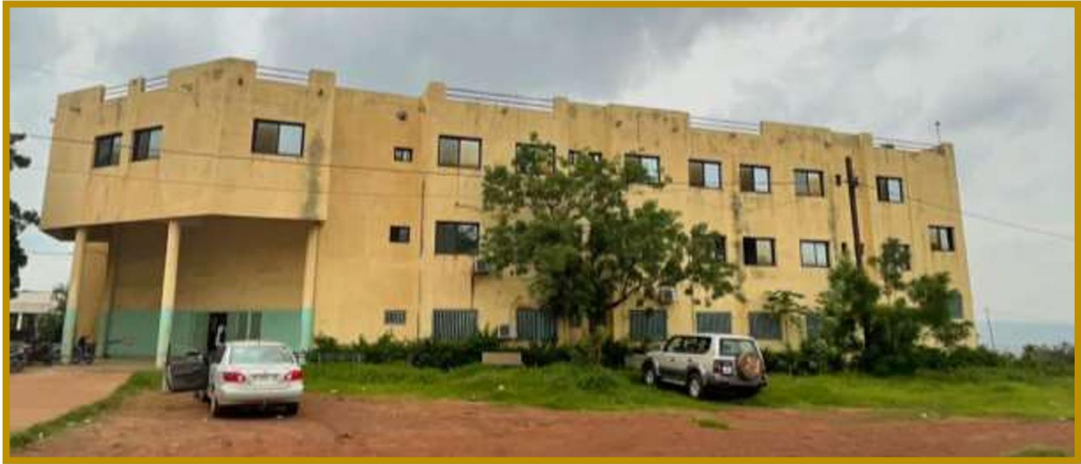
Photo 2 : Vue d'ensemble de face – Médecine Interne côté sud au bord de la route
