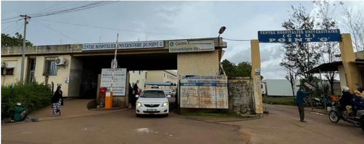
Photo 1 : Sortie à gauche et Entrée à droite du CHU Point G
